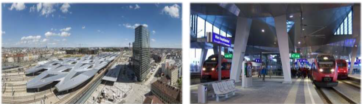
Рис. 2. Внешний и внутренний виды крупного интермодального узла ГОПТ «Главный вокзал Вены» (Wien Hauptbahnhof), г. Вена, Австрия
