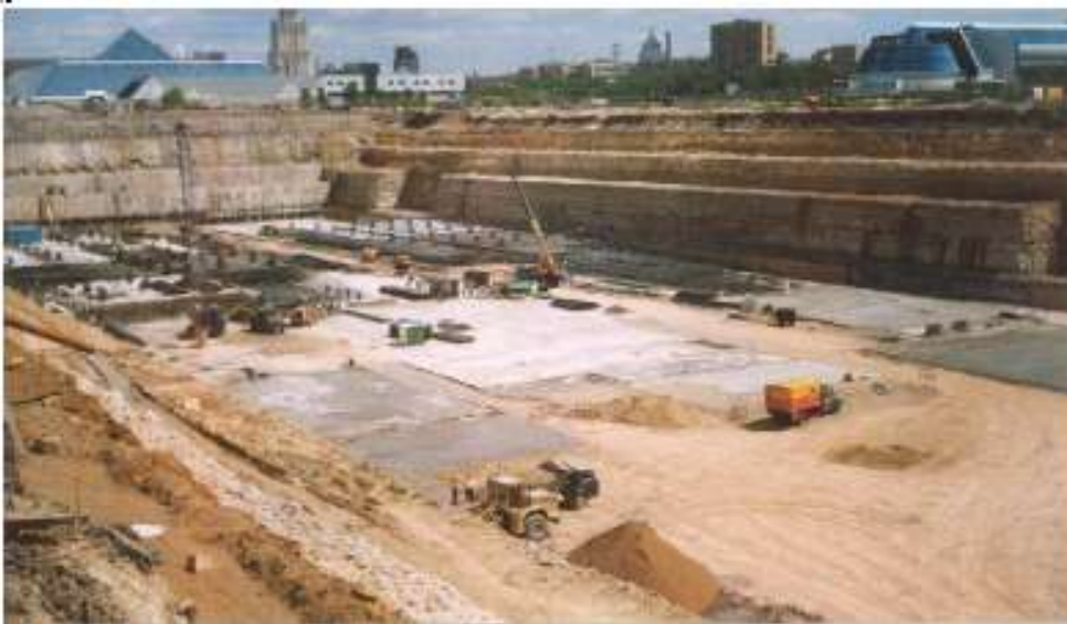
Рис. 1. Котлован Центрального ядра Международного центра «Москва-Сити» (1999)
