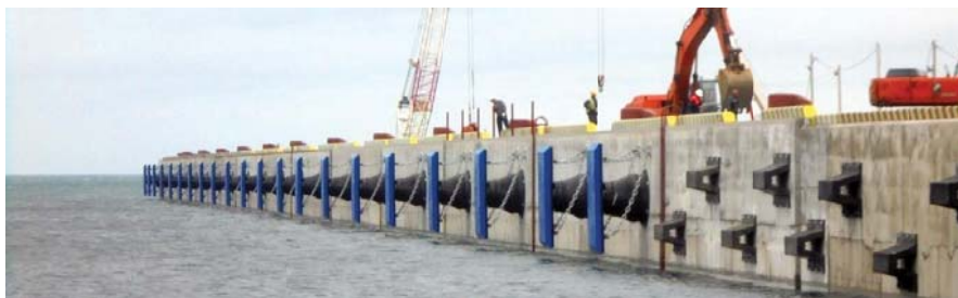
Рис. 2. Больверк, г. Пионерский, Калининградская область [11]
