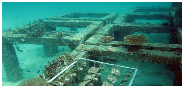
Рис. 7. Подводный волнолом в виде искусственных рифов вокруг о. Пхукет, Таиланд [17]
