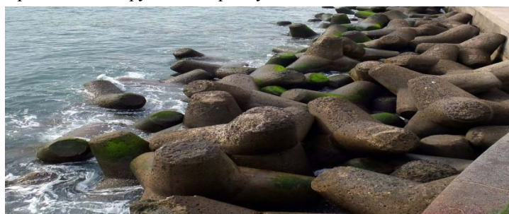
Рис. 3. Гравитационная стенка с набросом волнолома из тетраподов, г. Фуншал, Португалия [13]
