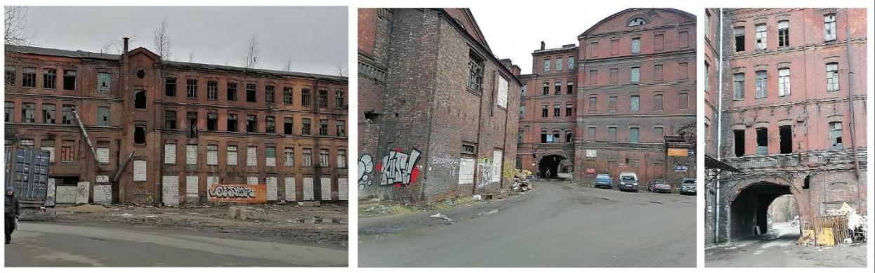
Рис. 3. Здания на территории завода «Красный треугольник». [22]
