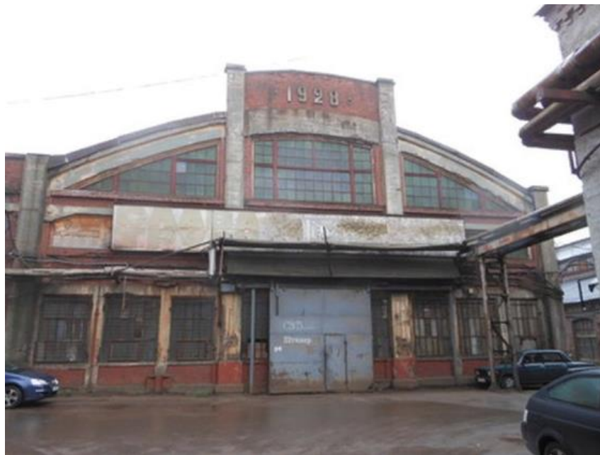
Рис. 1. Фасад кузнечного цеха (Б. Сампсониевский пр., д. 66, лит. О)
