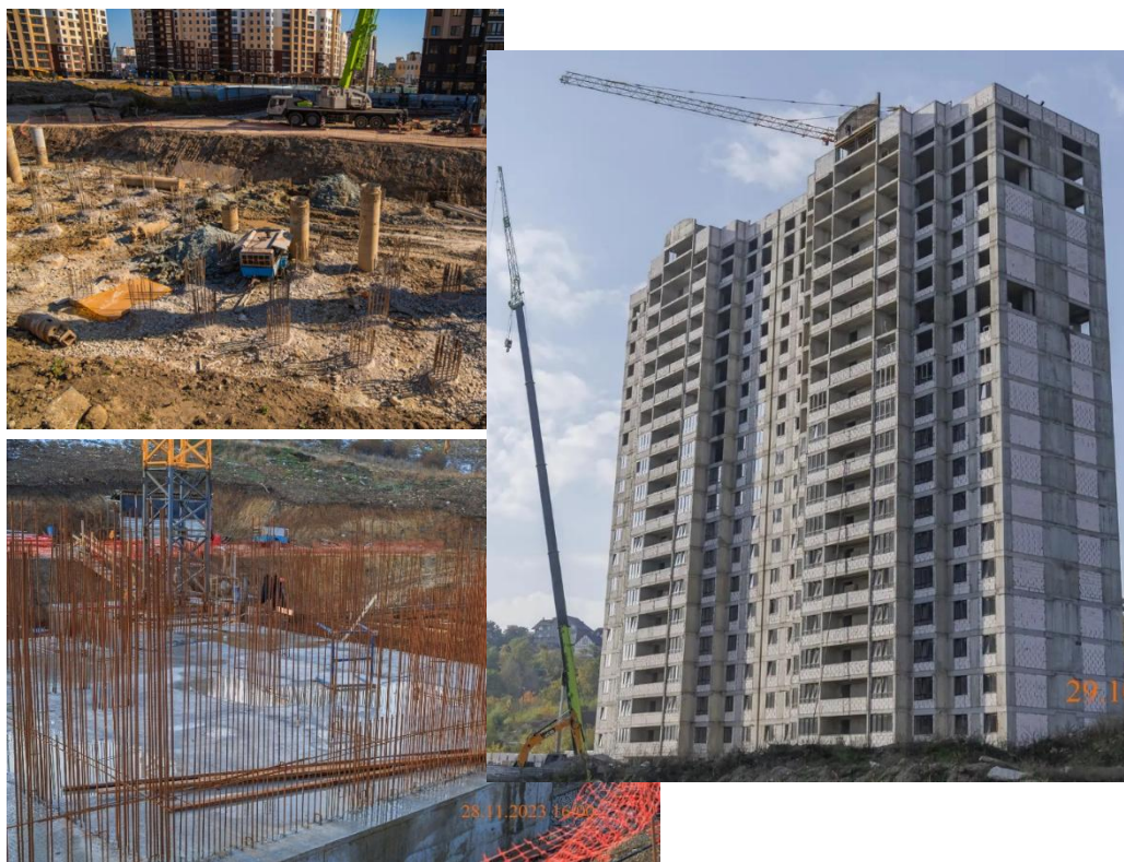
Рис. 5. Этапы устройства железобетонных конструкций нулевого цикла и степень готовности объекта на конец октября 2024 года
