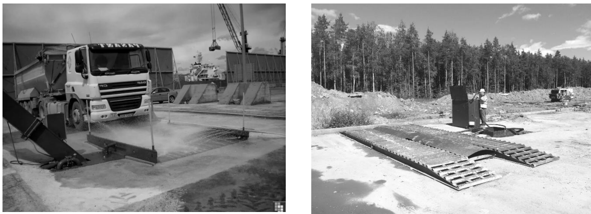
Рис. 2. Пункты мойки колес на стройплощадках
